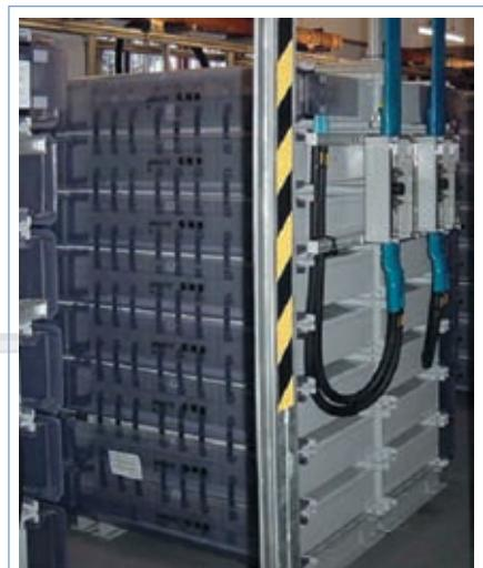
Рис. 10 Аккумуляторы Absolyte – установка в системе бесперебойного питания
