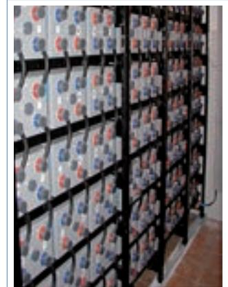
Рис. 19 Смонтированная батарея A600 OPzV (горизонтальное расположение)
