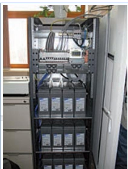
Рис. 15 Смонтированная батарея A412/120FT
