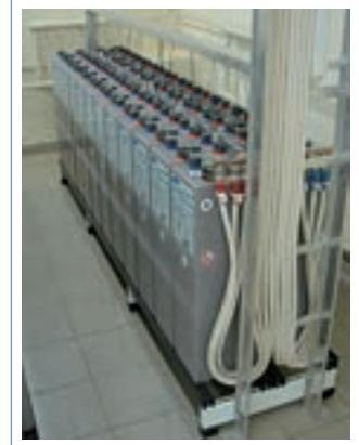
Рис. 18 Смонтированная батарея A600 OPzV
