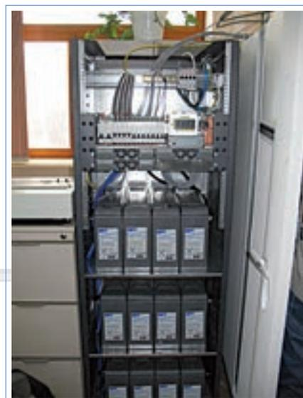
Рис. 15 Смонтированная батарея A412/120FT
