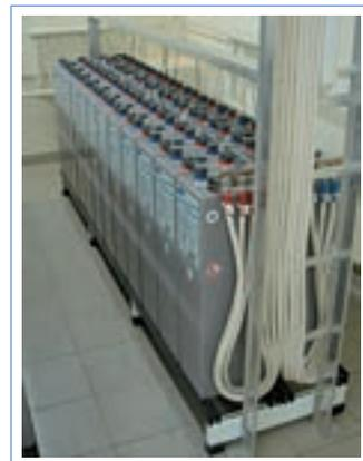
Рис. 18 Смонтированная батарея A600 OPzV
