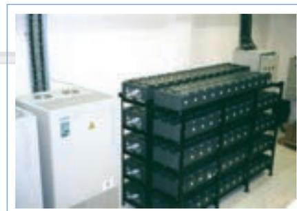
Рис. 16 Смонтированная батарея A500
