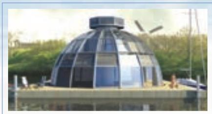
выставке, проводившейся в Голландии в 2009 году. Кульминацией выставки стал дом, построенный по типу иглу, оснащенный солнечными панелями, ветрогенератором и аккумуляторными батареями Sonnenschein A600 Solar. Иглу может устанавливаться как на водной поверхности, так и на суше. Он полностью независим от всех источников энергии, кроме
